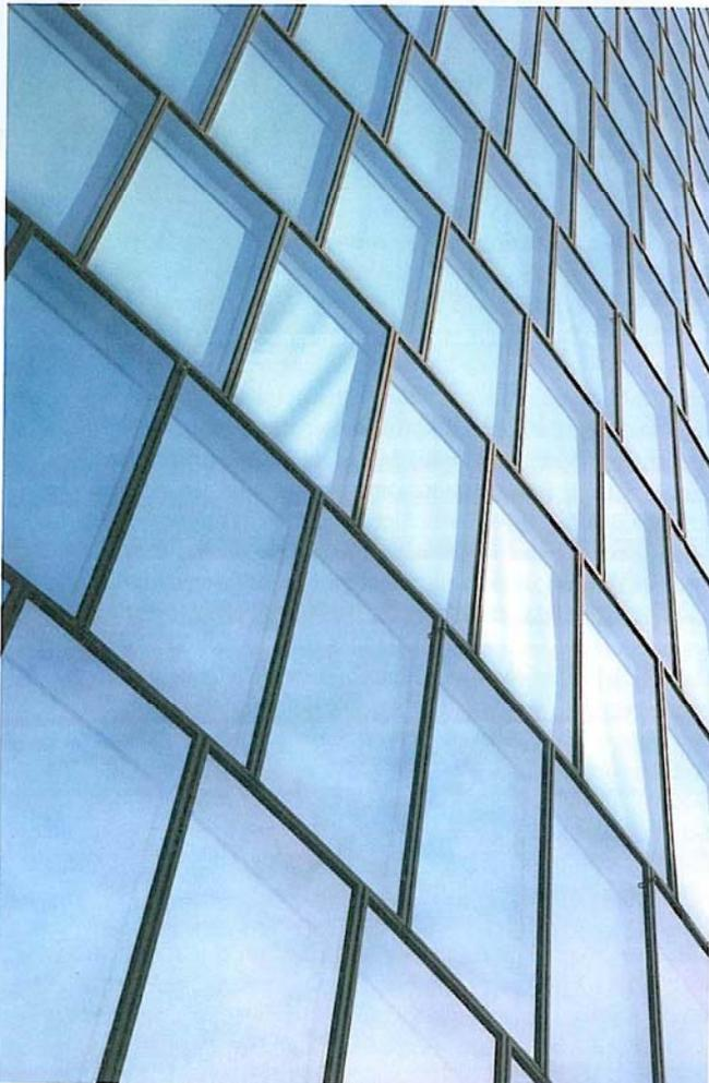
Versetzte Standardelemente mit leichter Neigung nach vorne: Die Geschoßflächen werden nach oben hin größer Standard facade panels with a slight inclination
